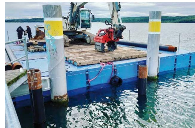
Flexible, einfache und ortsunabhängige Montage des Energie Pontons mit Hilfe einer schwimmenden Installationsplattform.
